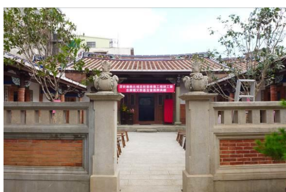
北埔忠恕堂修復後全貌
