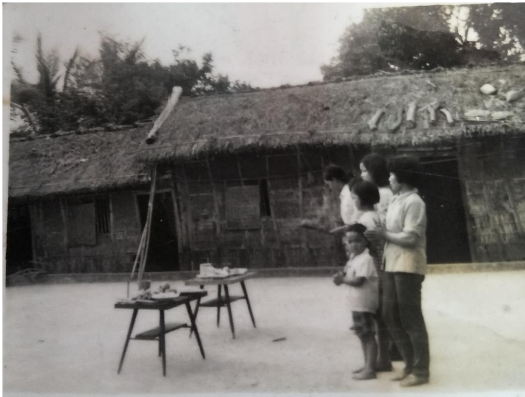
圖 4-1-1 蔗葉穿鑿屋 (1968 年/高姓住宅)
